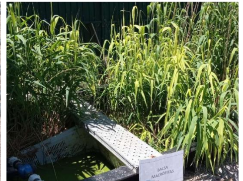
Detalle de filtros: Izda: filtro técnico CELTACAL; Centro: vermifiltro. Dcha: filtro de macrofitas
