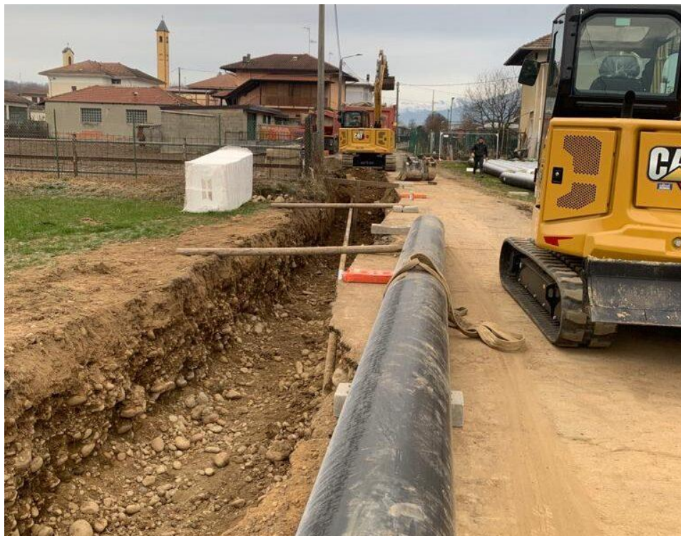
Detalle de obras de instalación de tuberías (Fuente: noticia local Provincia di Biella )
