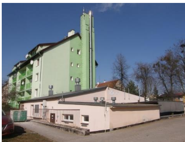
Instalación térmica de bomba de calor asociada a la escuela
