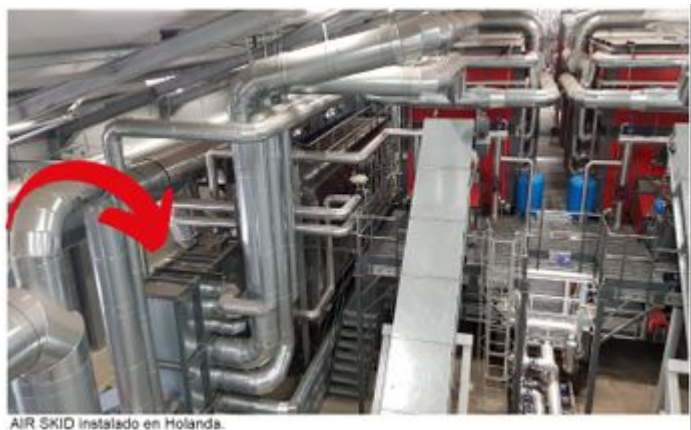
AIR SKID instalado en Holanda.
